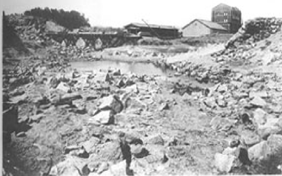
第二回洪水 新羅山防本堤崩壊川由乳京流線上手・於テ・状況 七月二十四日
