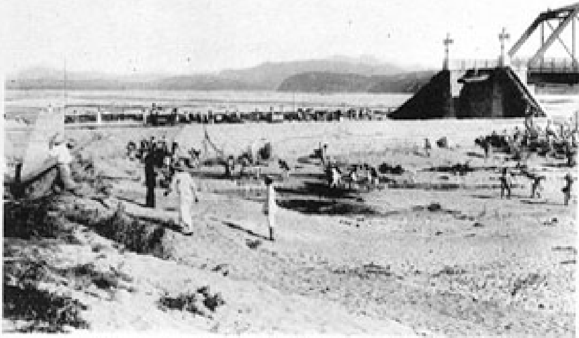
第二回洪水 廣江小橋取付道路總急復舊作業 七月二十三日
