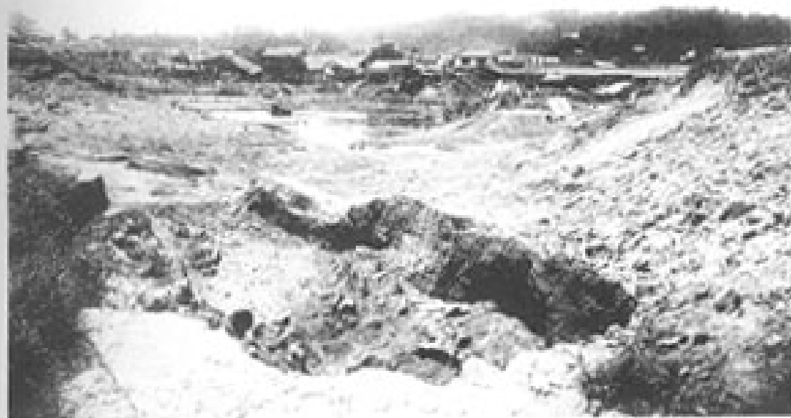
第二回洪水 新羅山防本堤崩壊川由乳京流線前・於テ・状況 七月二十四日
